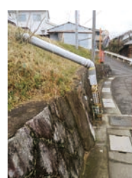
▲排水管を移設し道幅が広くなりました。
